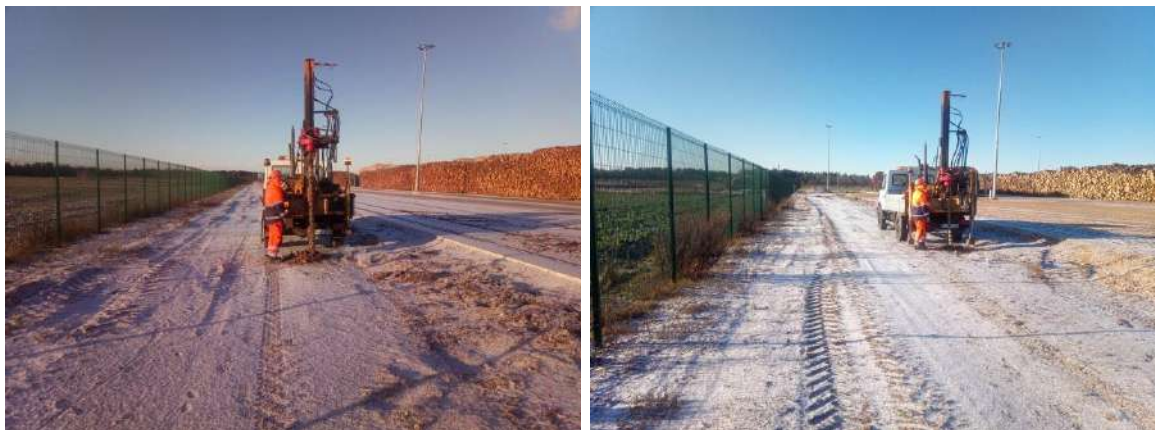
1 pav. Lauko darbai
