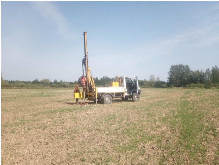
2 pav. Lauko darbai šalia gręžinio Nr.13
