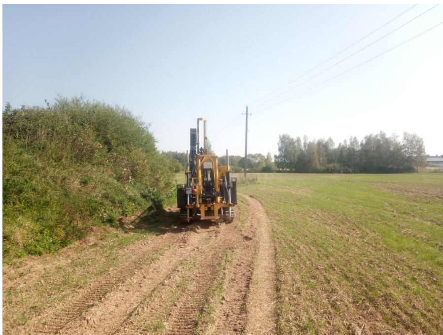
3 pav. Lauko darbai šalia gręžinio Nr.31
