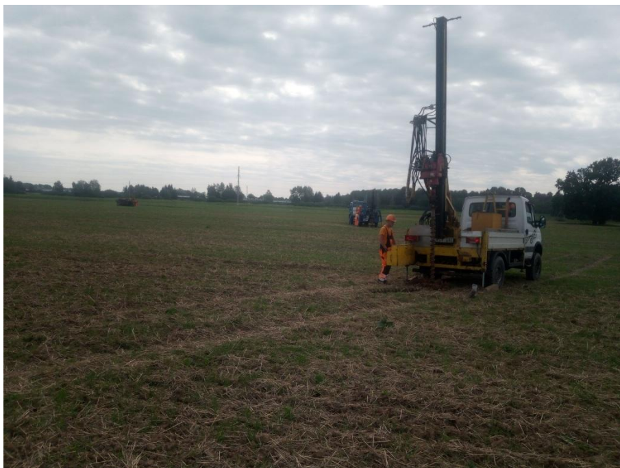
1 pav. Lauko darbai šalia gręžinio Nr.3
